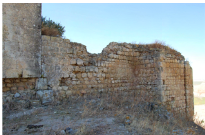
Figura 4. Lienzo que cierra el patio por el norte y torre noroeste. Se aprecia la acanaladura sobre el muro norte de la misma. Foto del autor
