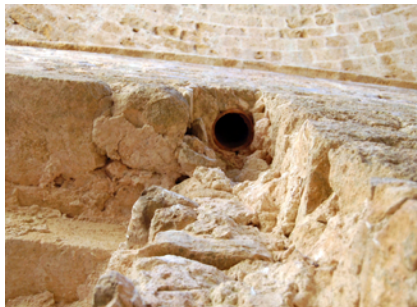
Figura 11. Sección del atañor, hecho de barro cocido y que discurre por el interior del muro norte. Probablemente aguaba en un pequeño aljibe bajo la cámara inferior. Foto del autor
