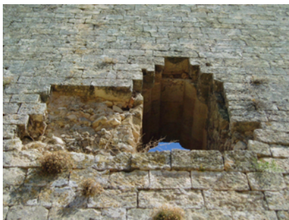
Figura 9. Ventana superior en la fachada sur, justo encima de la puerta de entrada. Se aprecian los modillones laterales así como la ausencia de matacán. Foto del autor
