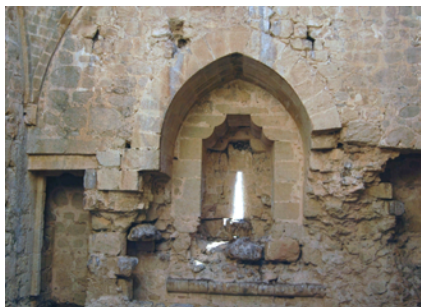
Figura 10. Ventana en interior de hornacina, situada en la planta superior justo por encima de la escalera. A ambos lados se observa la entrada y salida de la estancia. Foto del autor
