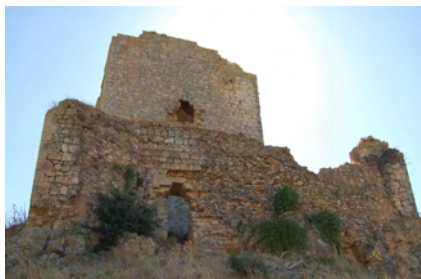
Figura 2. Acceso al castillo, situado en el alzado oeste de la camisa o muralla externa. Foto del autor
