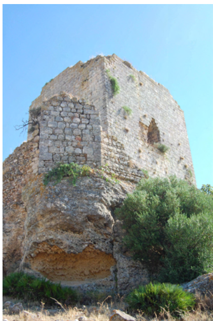
Figura 5. Torre que cerraba el ángulo suroeste, se aprecia cómo se levanta sobre la misma roca. Foto del autor
