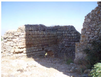
Figura 3. Ángulo formado por los lienzos de muralla que conforman el patio de entrada. Se aprecia la horizontalidad de las hileras de sillares. A la derecha de la imagen se pueden observar los restos del muro que cerraba el patio por el lado sur. Foto del autor
