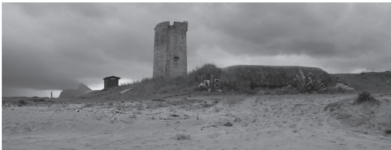
Búnker I.C.46, Torre Nueva y Peñón de Gibraltar, 2016 (fotografía de Alberto Atanasio)
