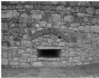
Figura 9. Detalle de la tronera del baluarte que mira al suroeste.
