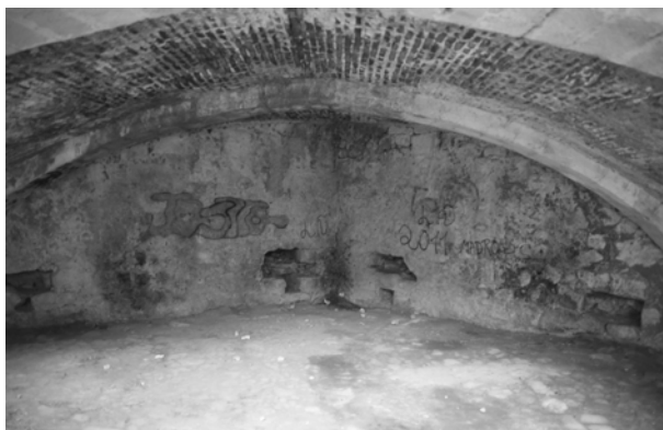
Figura 14. Vista de la proa del baluarte por el interior de la casamata.
