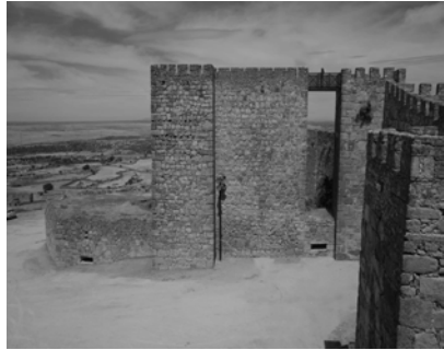
Figura 6. Vista del lado sur del baluarte con la torre albarrana del ángulo noroeste del primer recinto.
