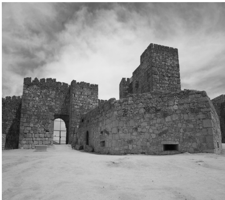
Figura 2. Vista del baluarte artillero con la puerta del segundo recinto o albacar
