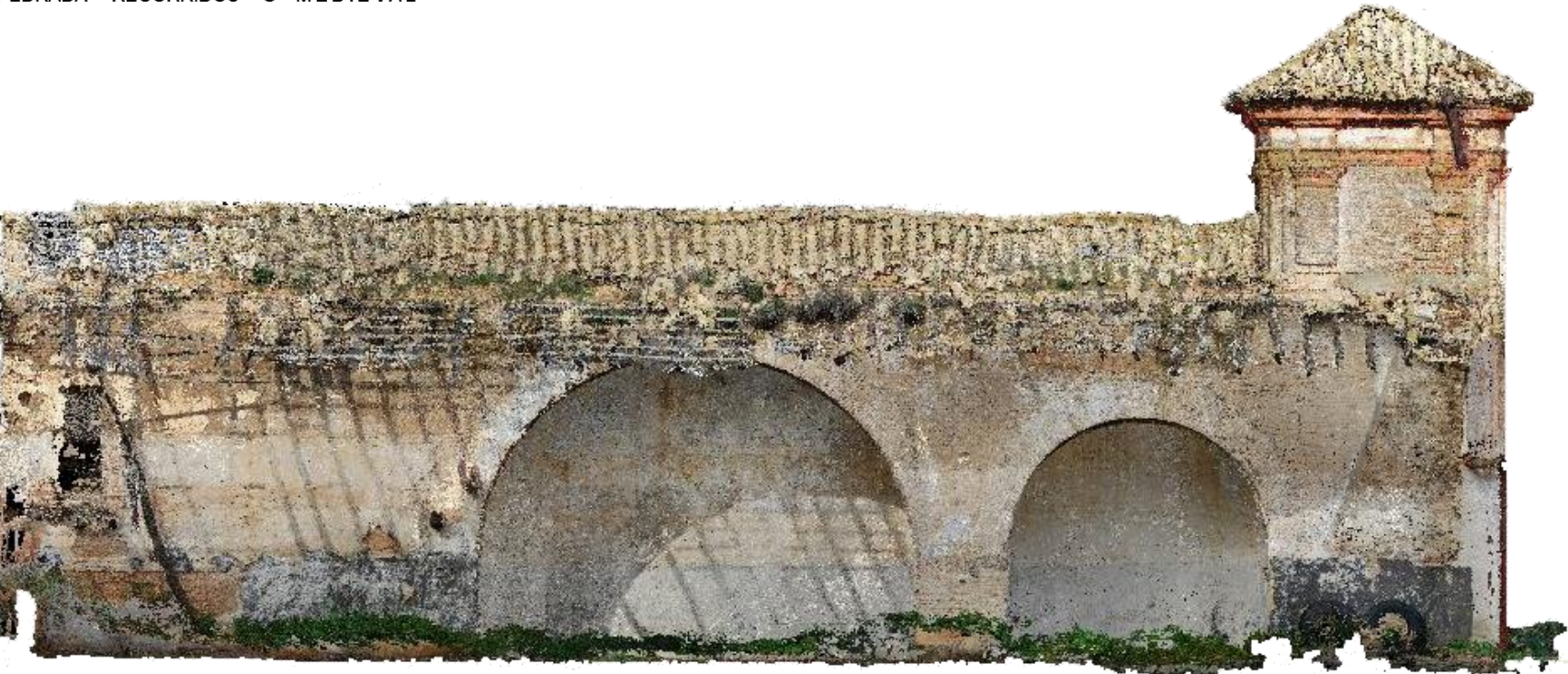
Nube de puntos obtenida mediante fotogrametría como base para el modelo HBIM. Molino de Charcón
