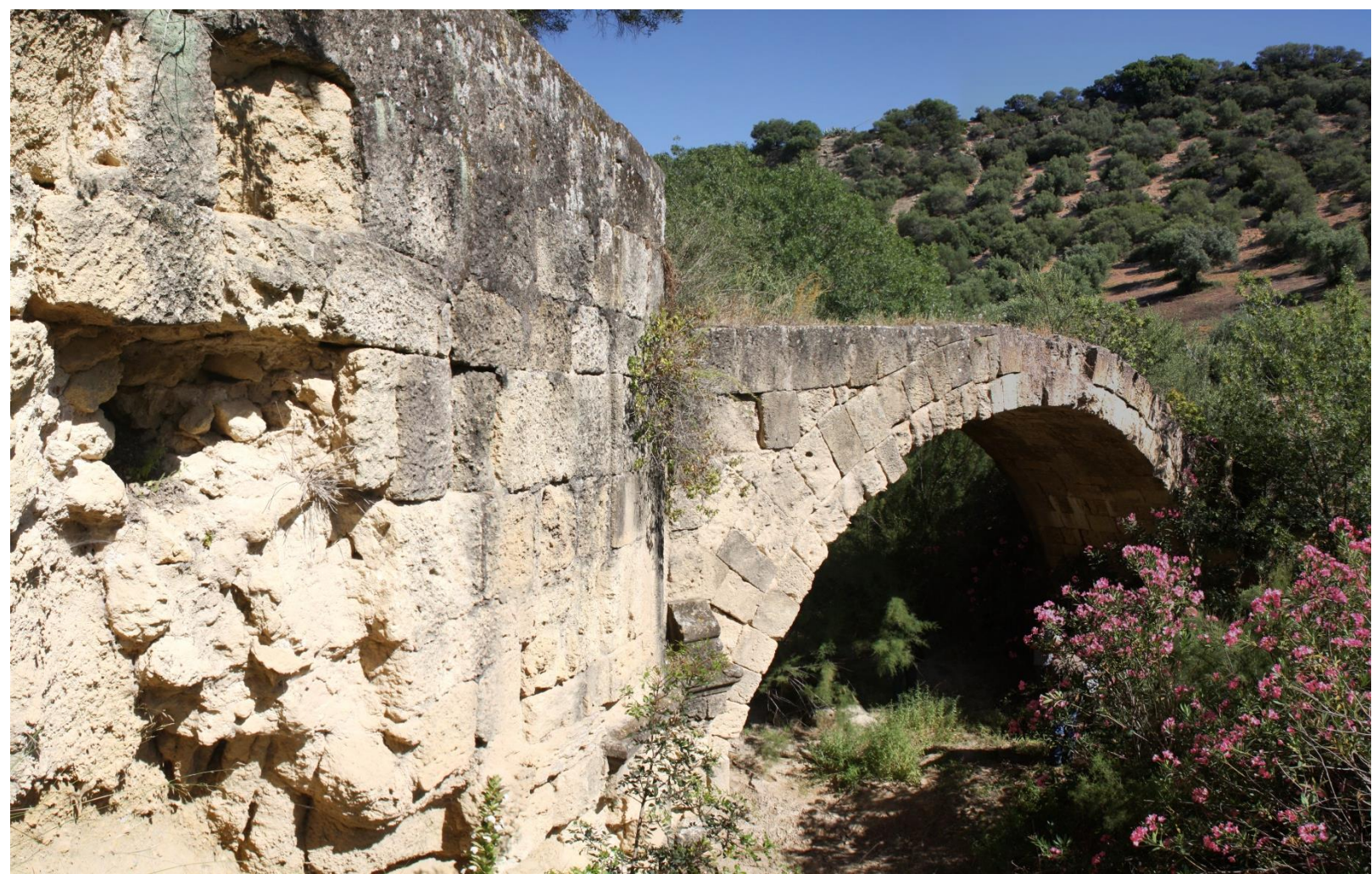
Medición del puente de Mogarejo, 2018.
