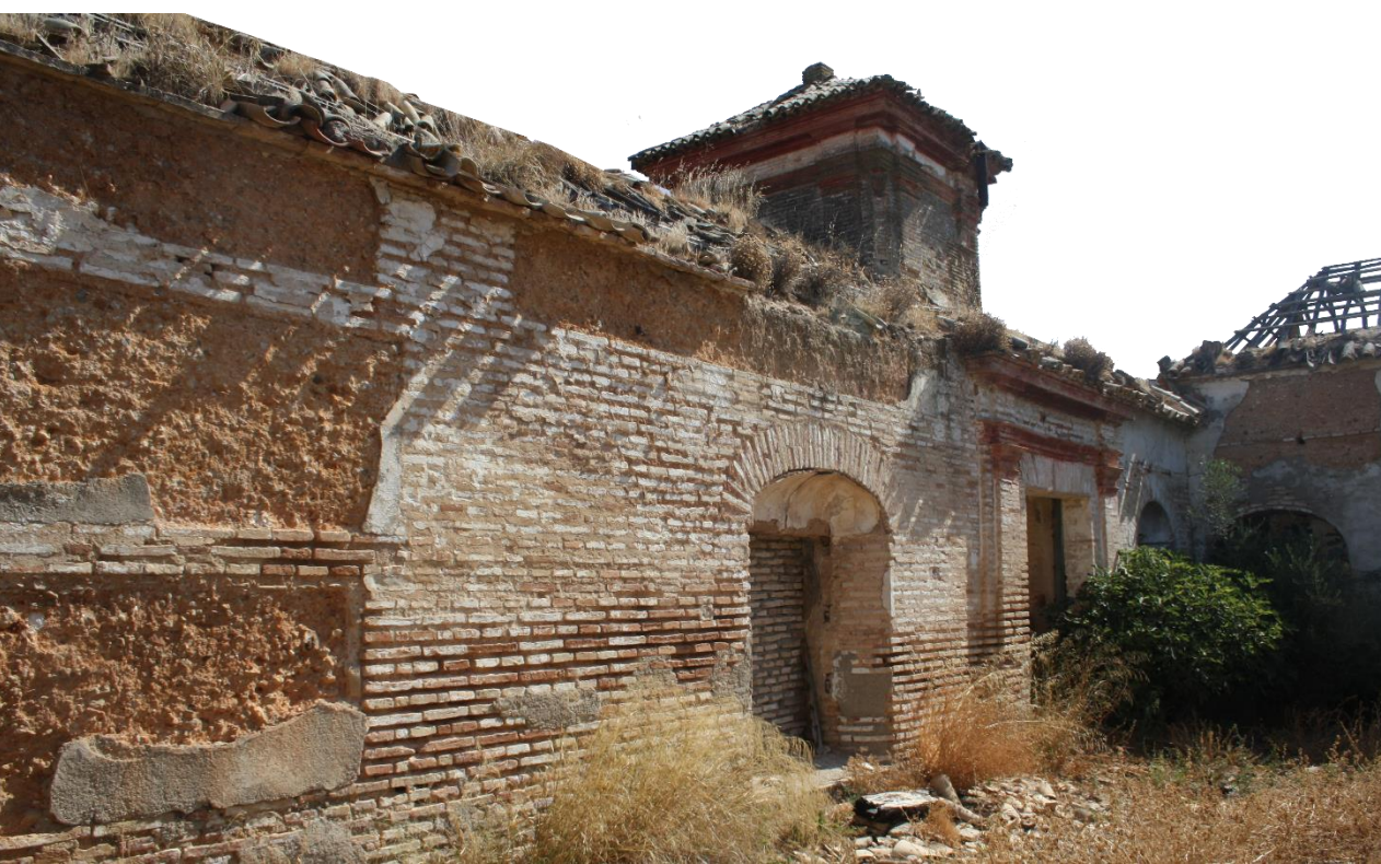
Tapia mixta con verdugada de ladrillo. Molino de Charcón
