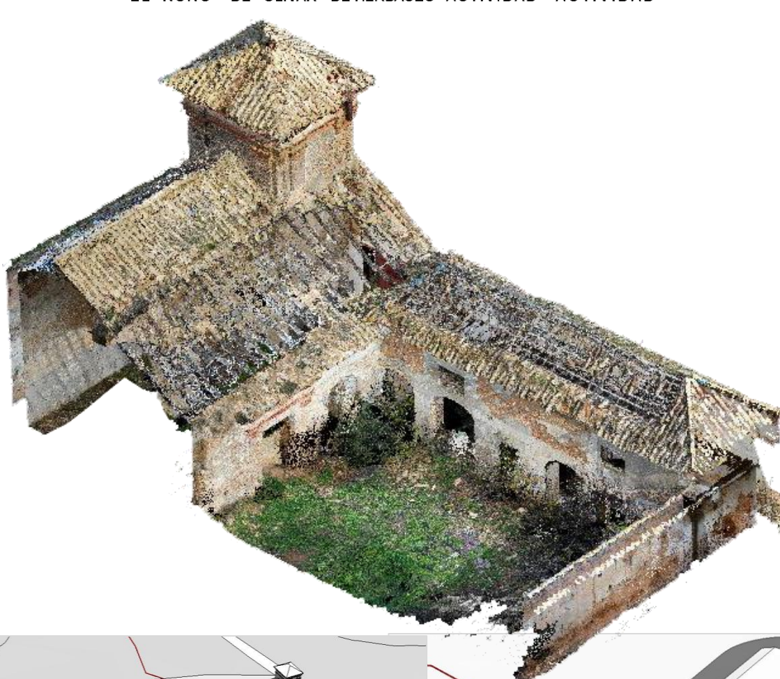
Nube de puntos obtenida mediante fotogrametría como base para el modelo HBIM. Molino de Charcón
