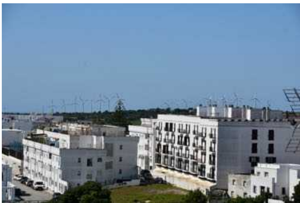
Figura 1. Parque eólico de Vejer de la Frontera. Fuente: elaboración propia.
