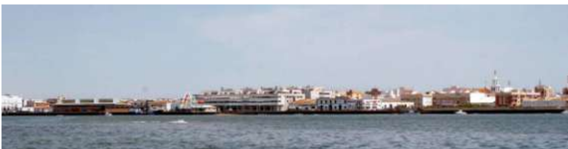
El Muelle Martínez Catena, frente urbano en la margen izquierda, concentra buena parte de las instalaciones portuarias.
